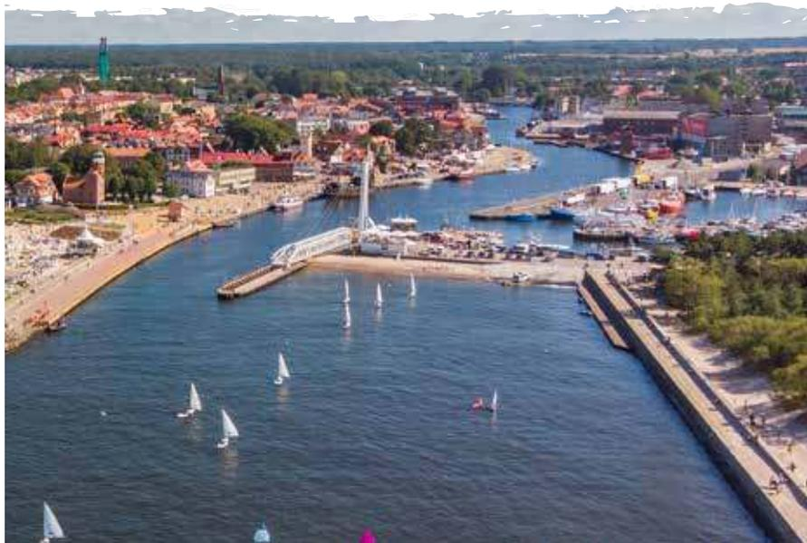
windigkeit 10 m/s nicht überschreitet. Der Pylon der Fußgängerbrücke, auf dem die Kamera montiert ist, die das Panorama des Hafens online überträgt, ist 24 Meter hoch. Die Länge der an 10 Stahlseilen hängenden Brücke beträgt über 57 Meter. Die Struktur wiegt 40 Tonnen und dreht sich um 85,5°. Bei Bedarf kann ein Fahrzeug mit einem Gewicht von bis zu 7,5 Tonnen die Fußgängerbrücke überqueren.
