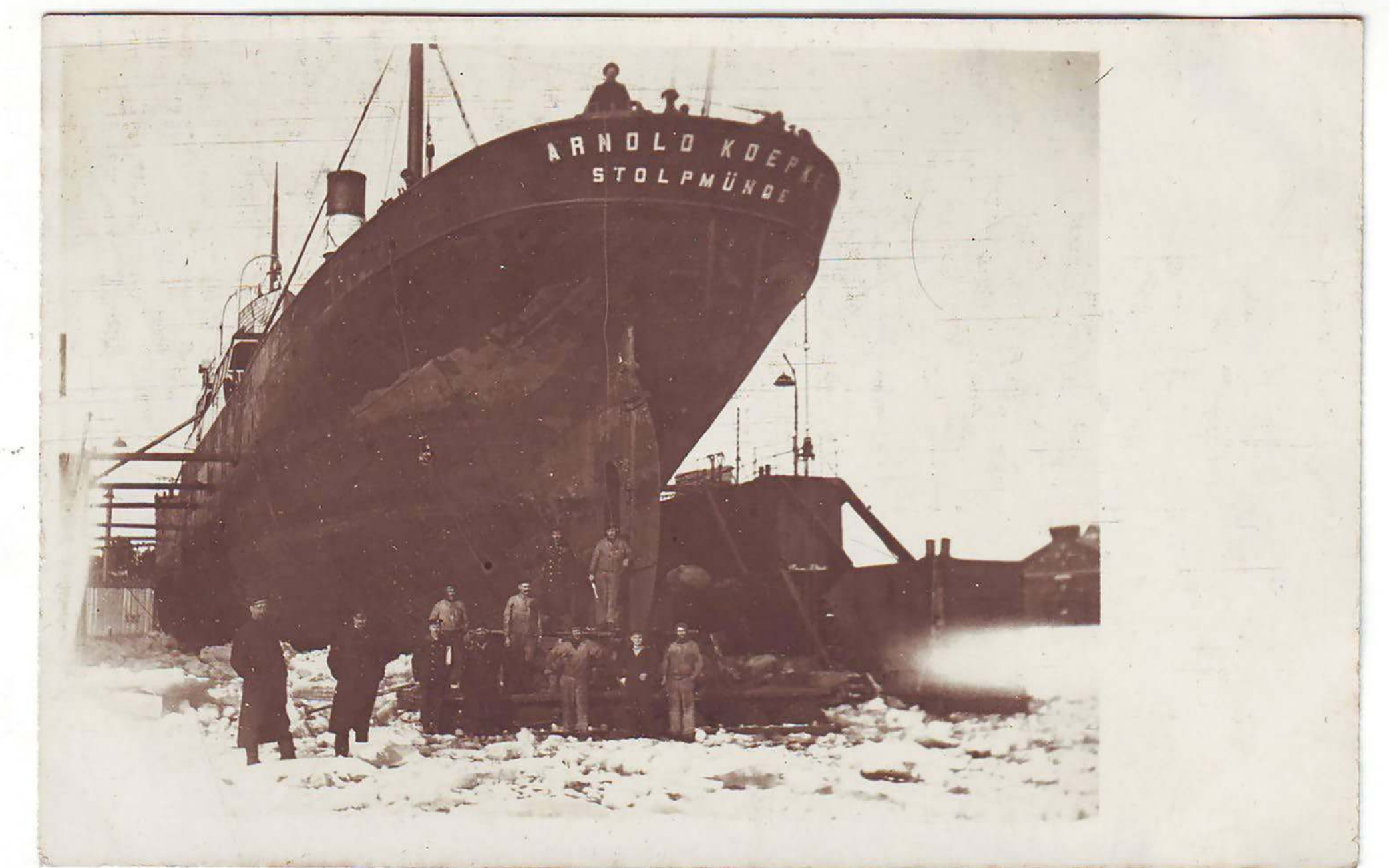
STATEK HANDLOWY ARNOLD KOEPKE PRZECHODZI NAPRAWY W USTECKIM PORCIE
