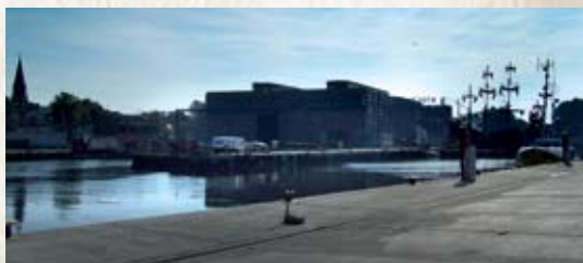
Hala, w której budowano do niedawna kadłuby stalowych statków.
