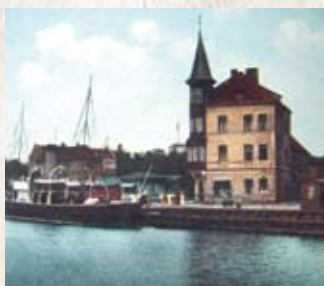
Siedziba firmy F. W. Koepke była jednym z najbardziej okazałych budynków w całej Uście.
