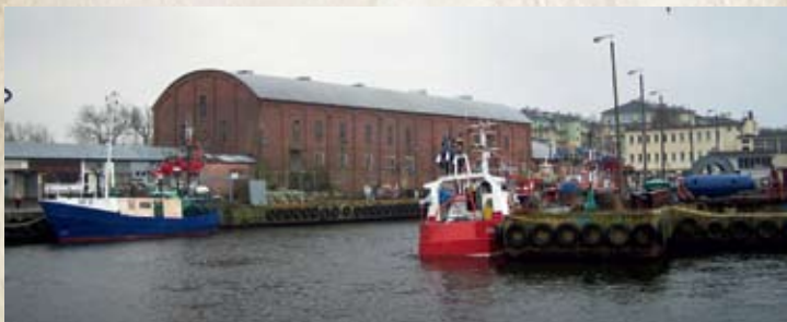
Magazyn spirytusu to ta okazała budowla z czerwonej cegły
